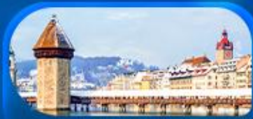
สะพานไมซ์าเปล
